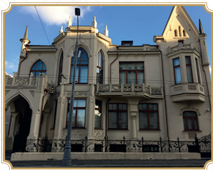
Дом пионеров на ул. Большая Полянка, д.45 (ныне Башмет-центр).
